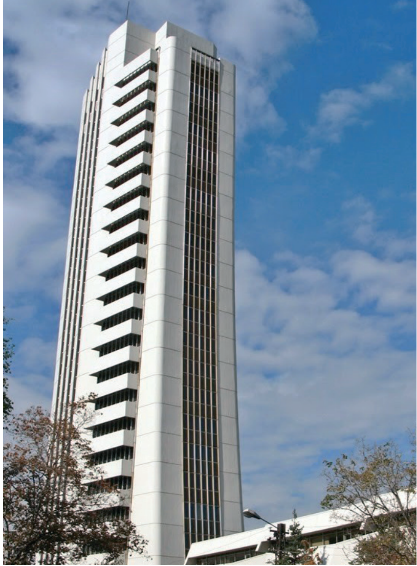
RESİM 1 - Bakanlık Ek Binası
